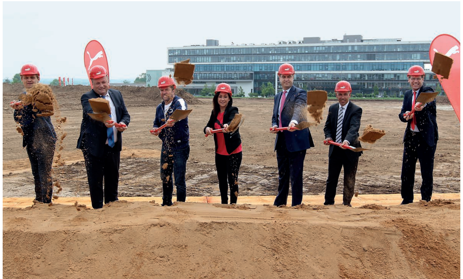
Spatenstich zum Neubau unserer Firmenzentrale im Mai 2016.
